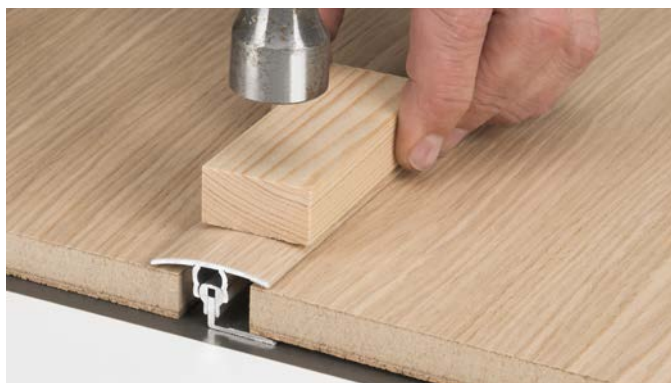
Instalace přechodového profilu hliníkového
