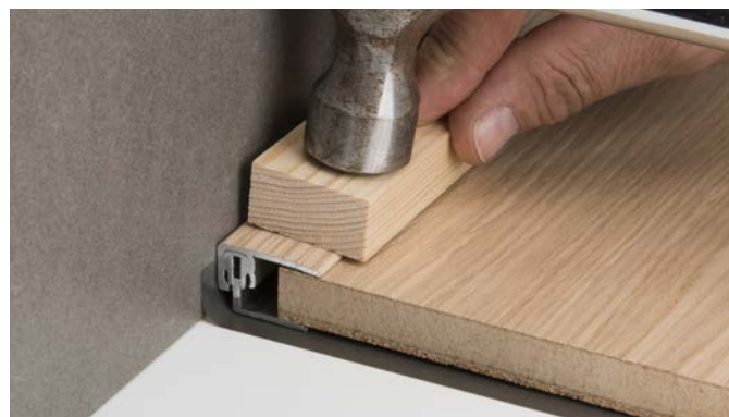
Instalace ukončovacího profilu hliníkového
